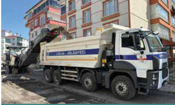
Trimer Yol Kazısı ve Asfalt Çalışması
