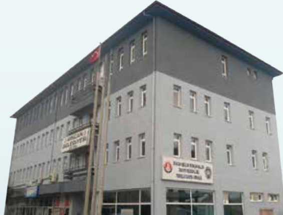
Temelli Ek Hizmet Binası
