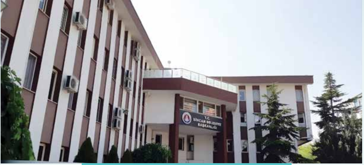
Sincan Belediyesi Ana Hizmet Binası
