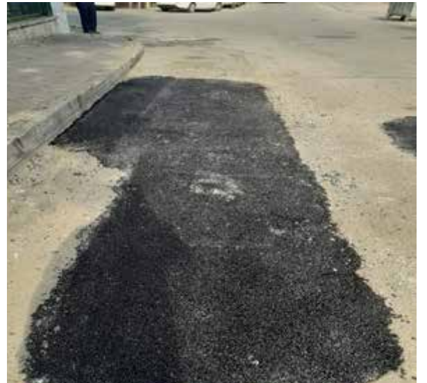
Asfalt Yama ve Bozuk Zemin Düzenleme Çalışmaları
