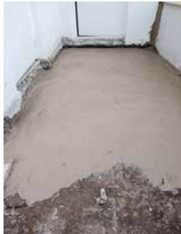
Karo Tamirâtı ve Beton Atımı Çalışmaları
