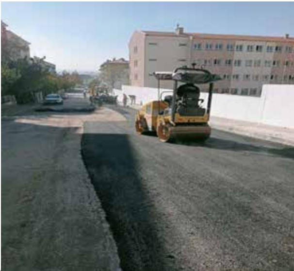
Silindir Çalışmaları
