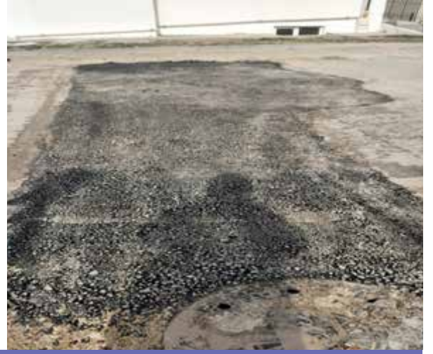
Bağlantı Kazısı Sonrası Asfalt Çalışması
