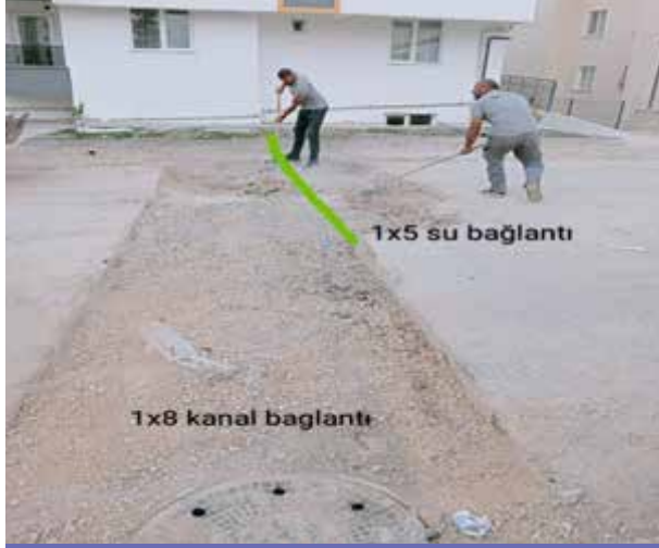
Bağlantı Kazısı Sonrası Asfalt Çalışması
