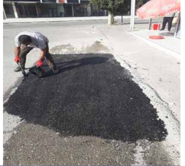
Asfalt Yama ve Bozuk Zemin Düzenleme Çalışmaları
